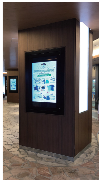
某商業施設 柱埋込
