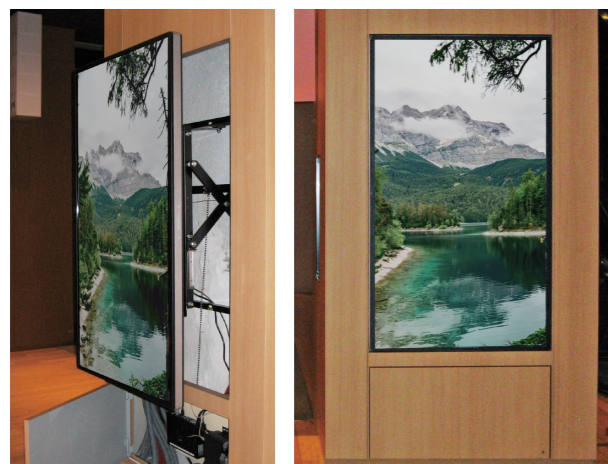
某商業施設 大型ディスプレイ埋込設置
