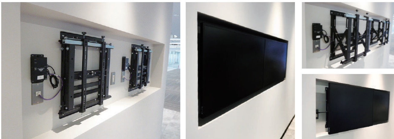
某施設 大型ディスプレイ埋込設置
