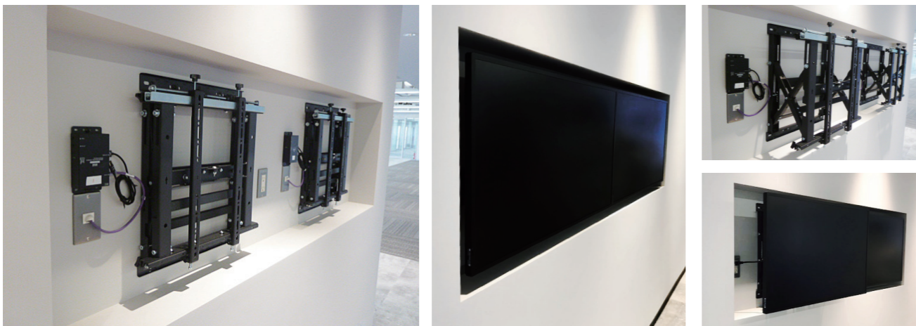
某施設 大型ディスプレイ埋込設置
